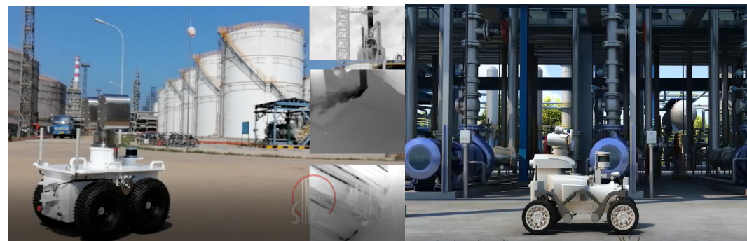
(b) 机器人移动端泄漏、声音、温度、火焰等异常走航巡检
